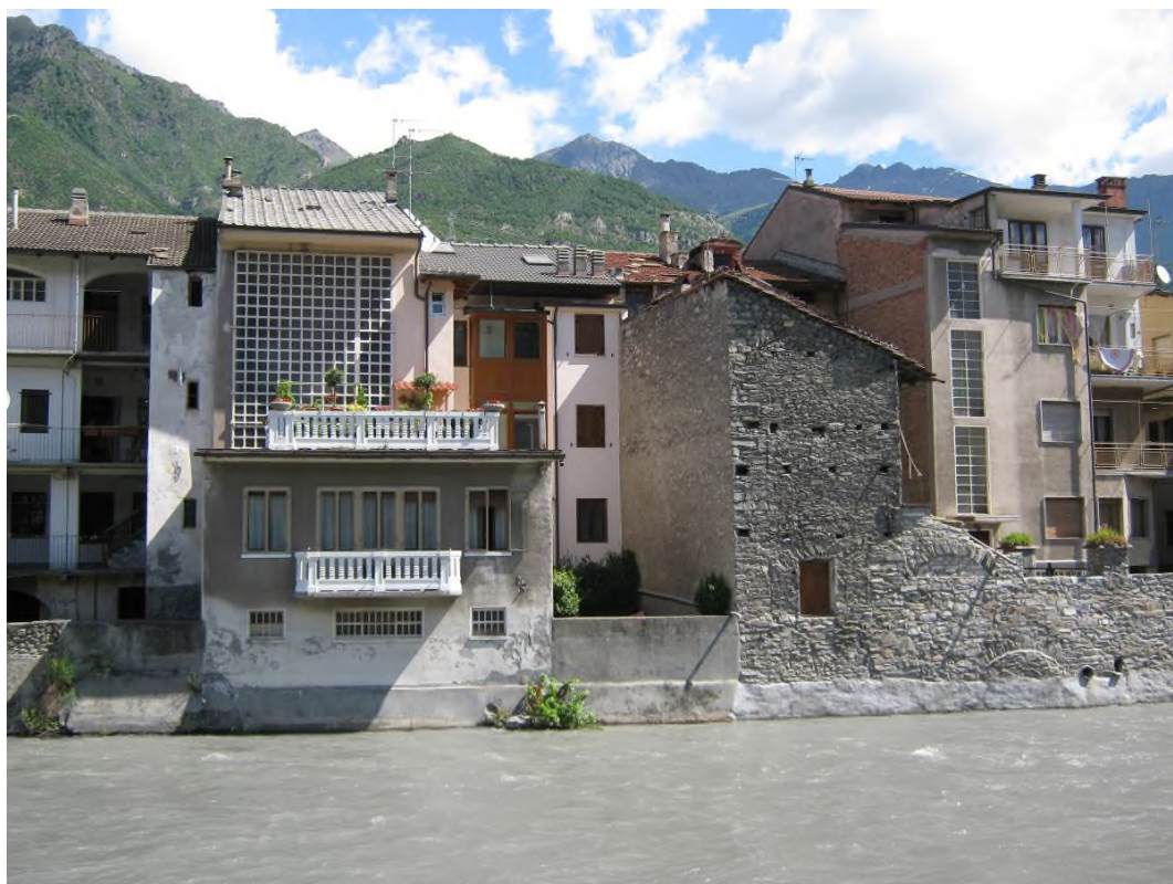
Foto 24– Tratto a valle del ponte Vecchio: muro perimetrale del cortile interno, trascinabile.
