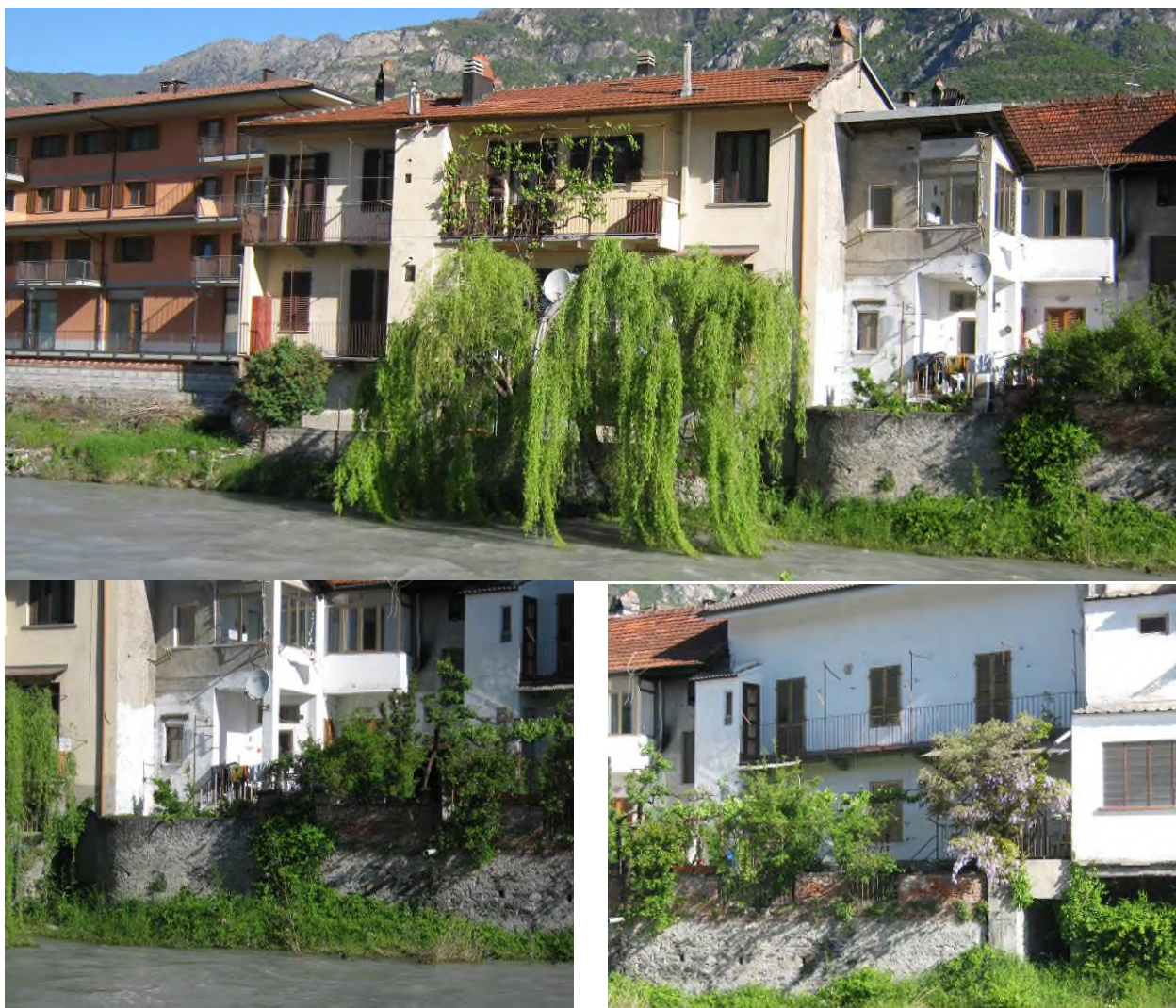
Foto 15, 16 e 17 – Tratto a valle del ponte di Ferro: muri privati insufficienti a contenere la piena.
