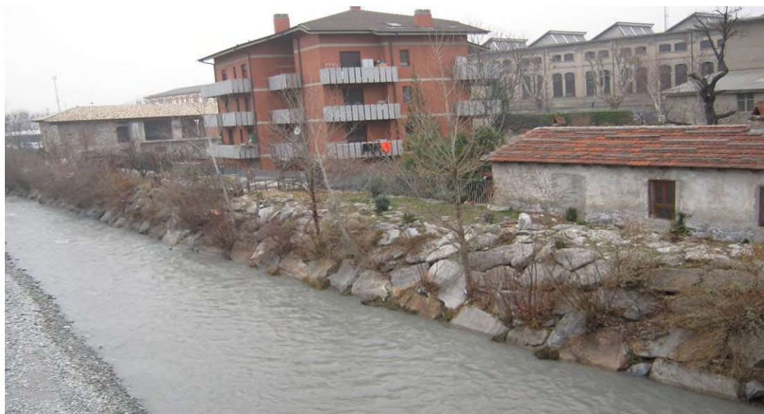
Foto 8 – Tratto a monte del ponte di Ferro, in cui la sponda è attualmente protetta da una scogliera in massi.
