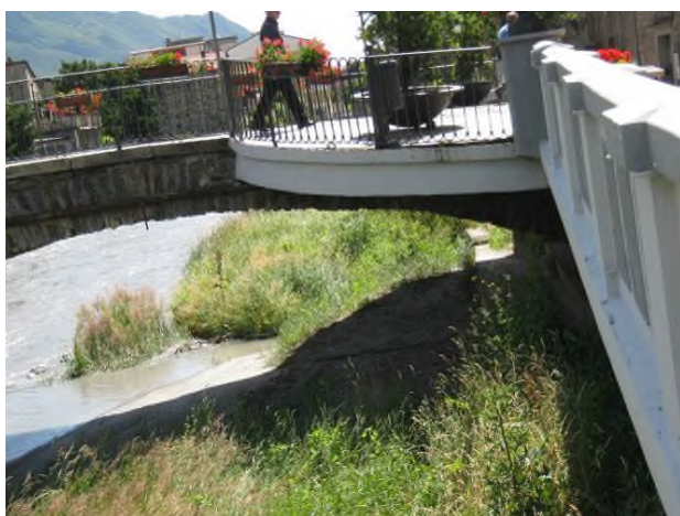
Foto 30 e 31 – Particolare delle piazzole pedonali presenti all'imbocco del Ponte Vecchio in sponda destra e del deposito di materiale che ostruisce parzialmente le luci del ponte.
