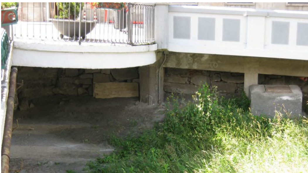
Foto 29 – Particolare del muro in pietra originario, arretrato rispetto al parapetto di recente costruzione.
